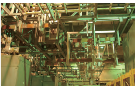
実験室送電線
