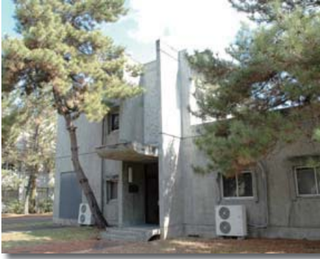
北1号棟 (エネルギーナノサイエンス研究棟)
