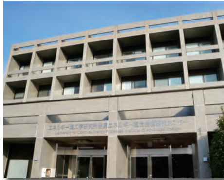
北4号棟 (ヘリオトロン核融合研究棟)
