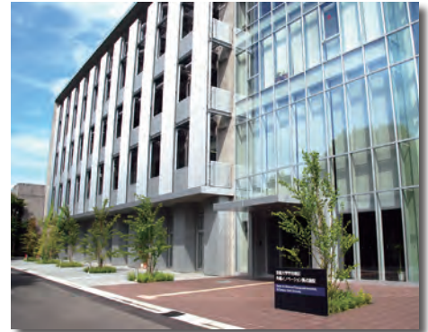
宇治地区先端イノベーション拠点施設
