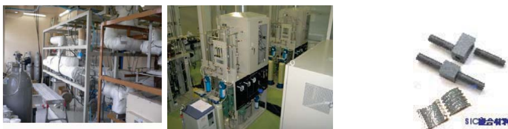
図1：南1号棟に設置された原子力システム模擬ループ
