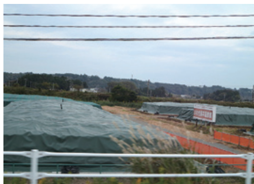
写真 1 除染廃棄物の一次保管場所
